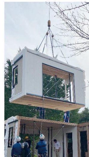
▲現場での施工風景
