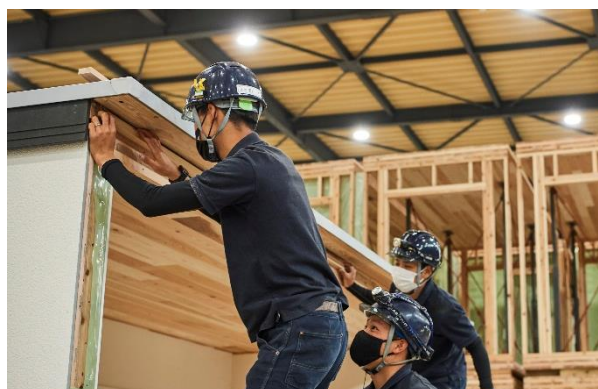
▲工場内での作業風景
