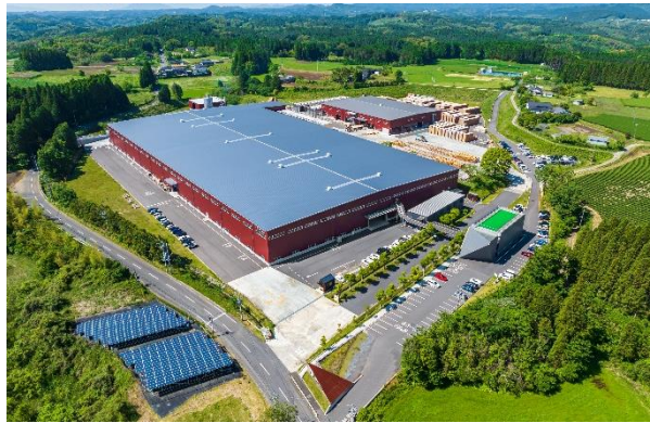
▲鹿児島湧水工場（全景）
