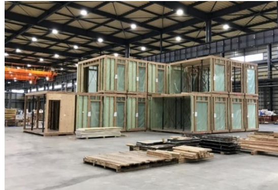
▲工場内で組み立てられた MOKUWELL HOUSE ユニット
